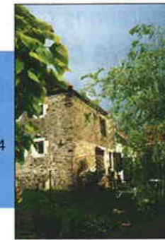
Mme Van de Zande Chaudière De Dietrich Gt 114 et régulation Diematic
