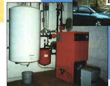
M. & Mme Morin à Fléron Installation complète d'un chauffage au gaz naturel. Chaudière à évacuation forcée Atmon Elco Klöckner. Radiateurs Def - tuyauteries cuivre en vides ventilés.
