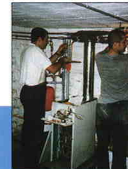
M. & Mme Malchair à Richelle Installation complète d'un chauffage au gaz naturel Chaufferie en cours de montage: chaudière Chaffoteaux & Maury + accu gaz Neotherme
