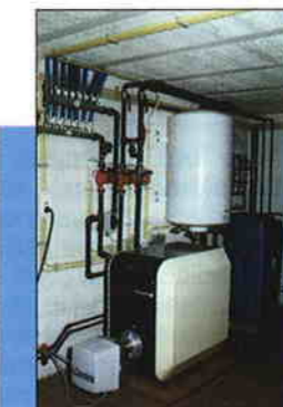
M. & Mme Craninx Rénovation très profonde de 2 anciennes maisons contigues. Chauffage par le sol (ici après chapes !) chaudière De Dietrich GT 115, brûleur Elco Klöckner, régulation Diematic delta
